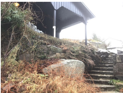
Støpt trapp fra gårds plass
