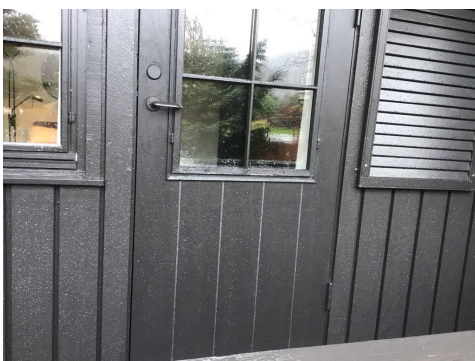
Balkongdør på soverom
