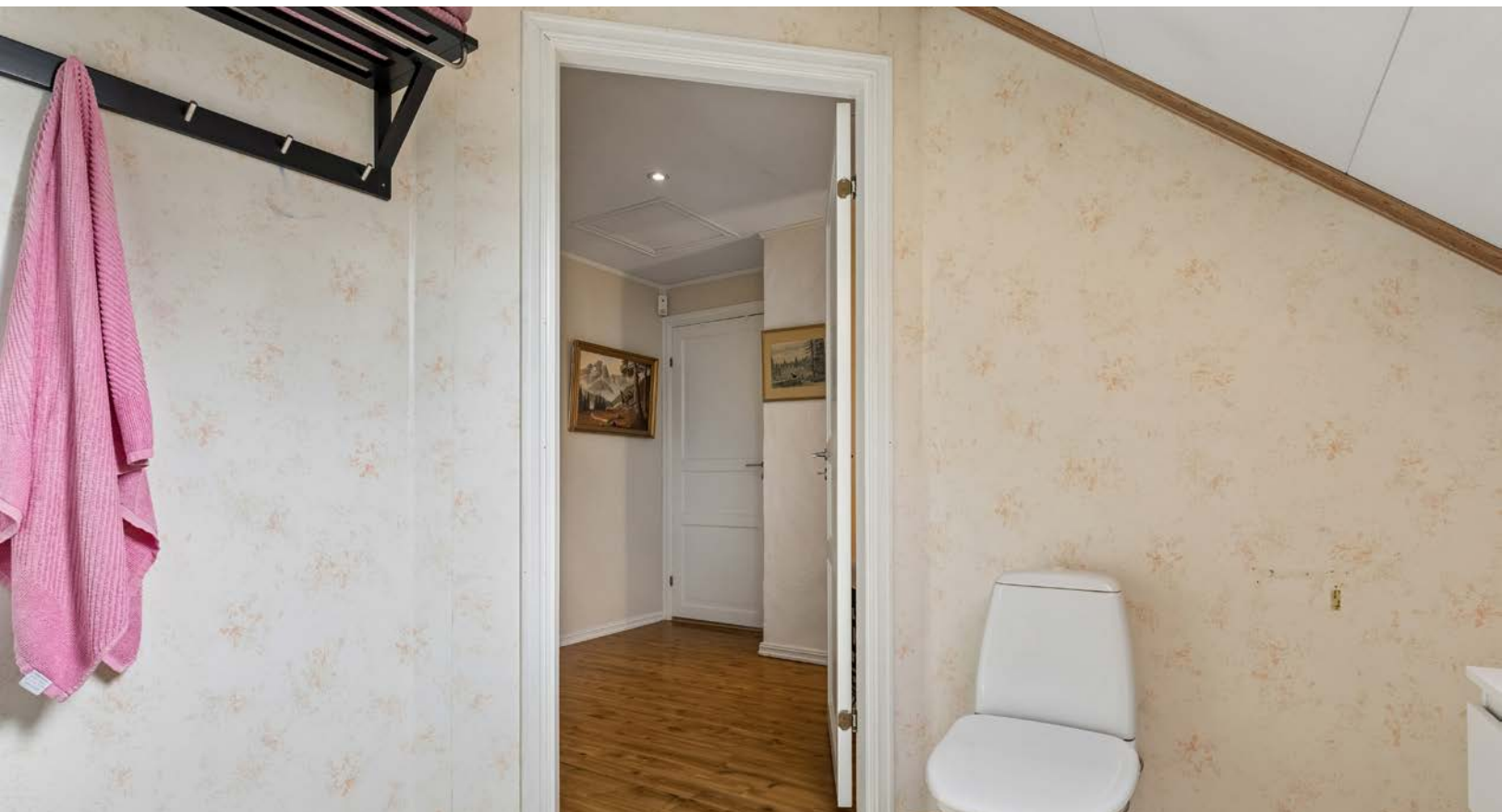
Badet har vinylbelegg m/oppbrett på gulv og vinyltapet på vegger.
