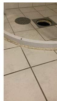
Tett list som stenger lekkasjevann fra å renne til sluk.
