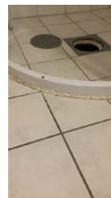
Tett list som stenger lekkasjevann fra å renne til sluk.
