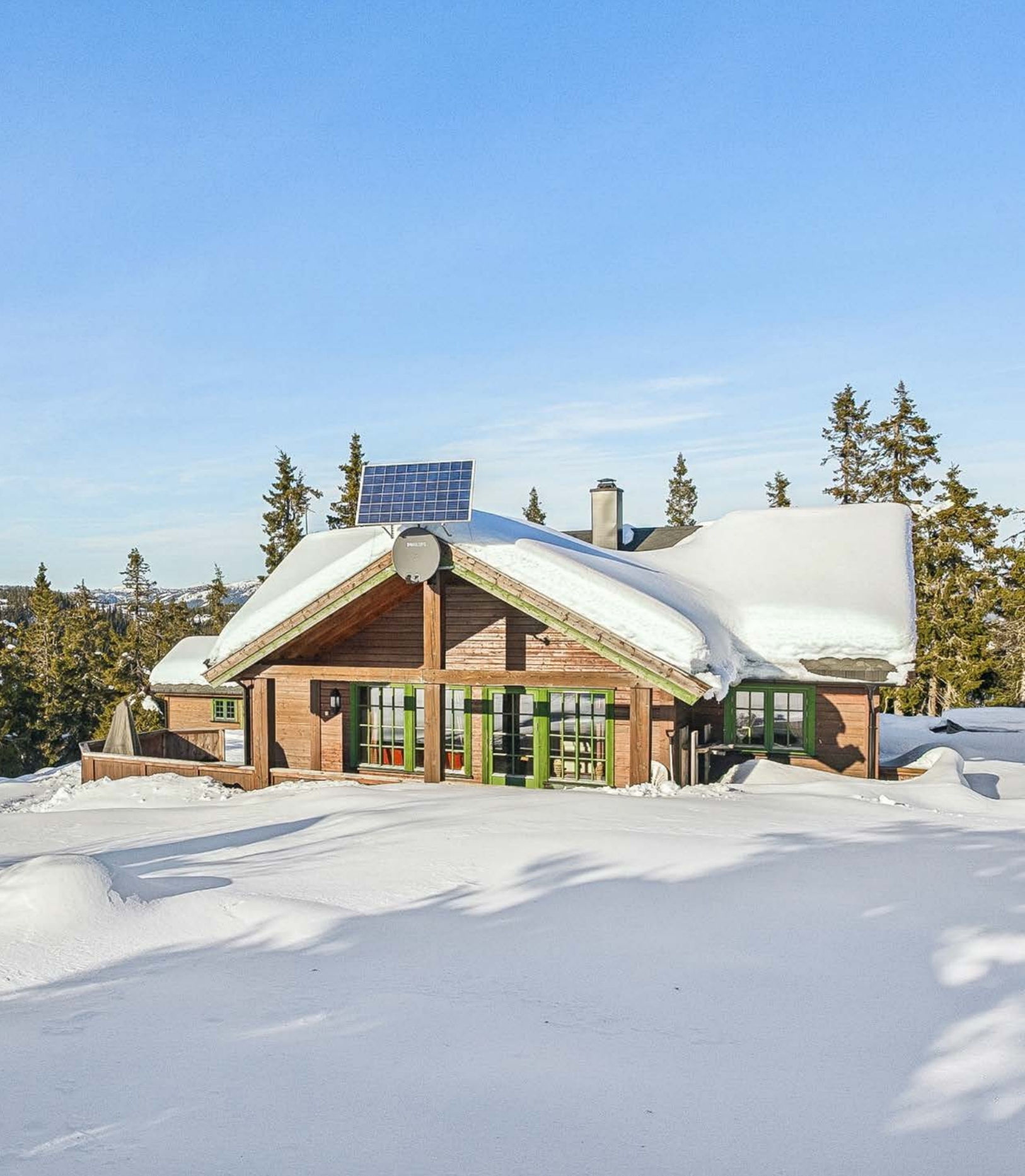
Hytte med solcelleanlegg som gir energitilførsel.
