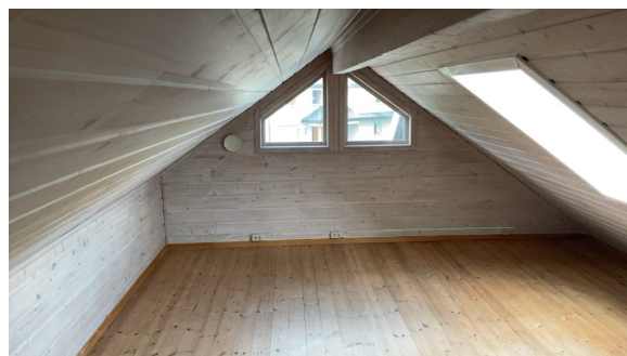
Takkonstruksjonen er gjenbygget.
