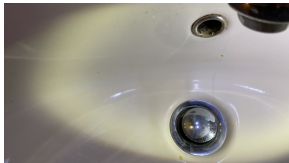
Det er påvist riss/sprekker i utstyr på våtrommet.
