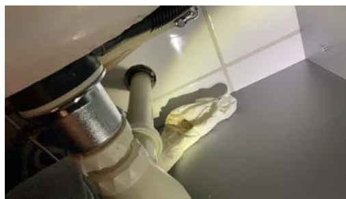
Utilfredsstillende tetting ved rørgjennomganger
