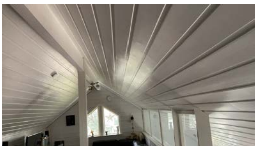
Storedele av takkonstruksjonen er gjenbygget.
