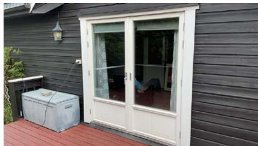
Balkongdør i 1. etg fra 2015.
