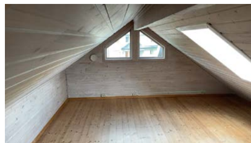
Takkonstruksjonen er gjenbygget.
