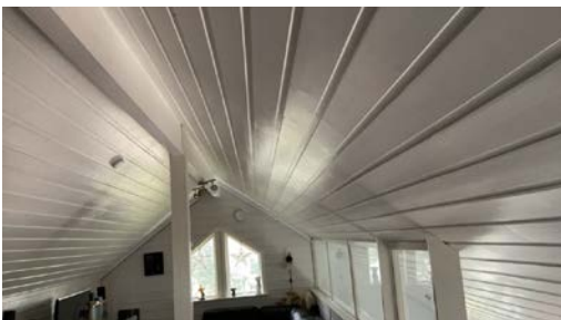
Storedele av takkonstruksjonen er gjenbygget.
