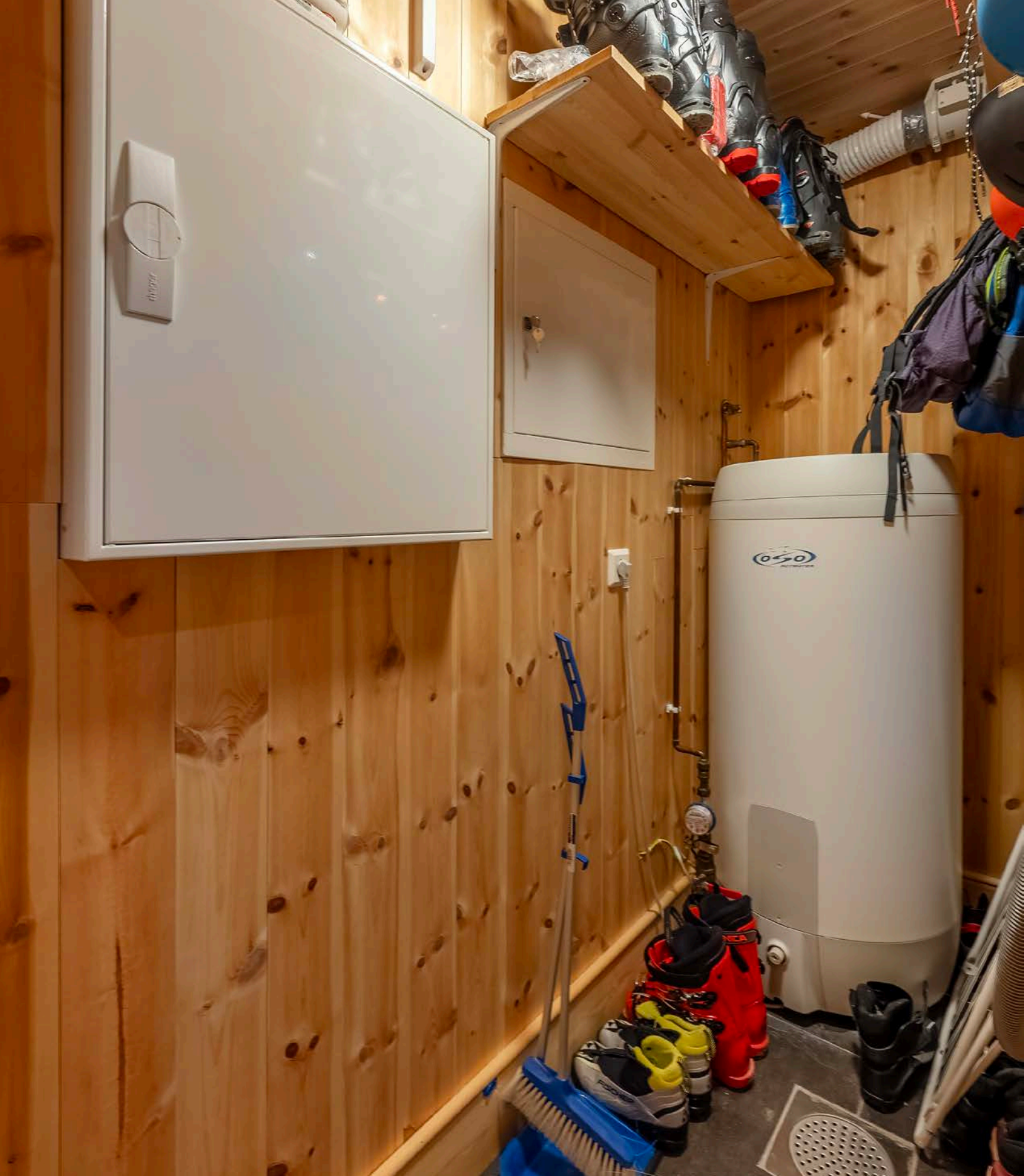
Teknisk rom (sokkeletasje)
