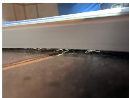
Vann kan renne under dusjvegg til sluk
