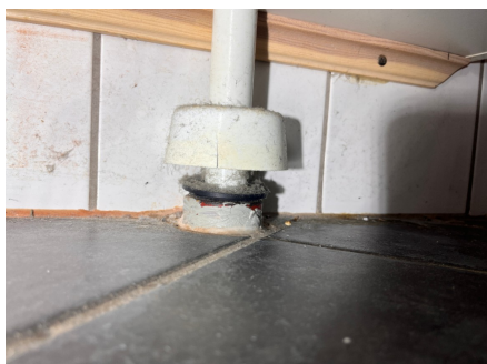
Membran på rørgjennomføring i gulvet
