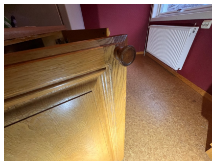
Bruks slitasje på fronter.
