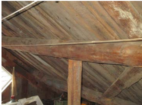
Åsetak med undertak av under og påbord.
