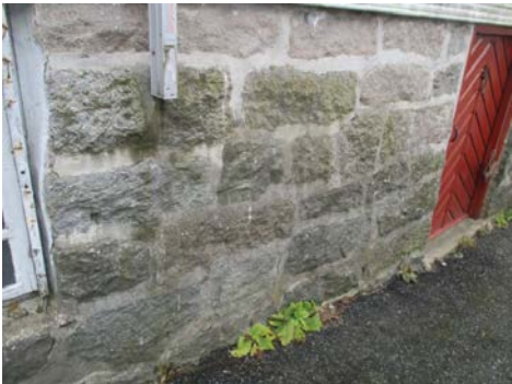
Tykk grunnmur av natursteinsblokker.
