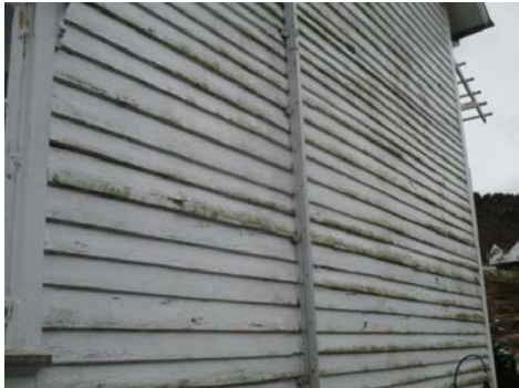
Eldre opprinnelig liggende kledning av tykke bord.
