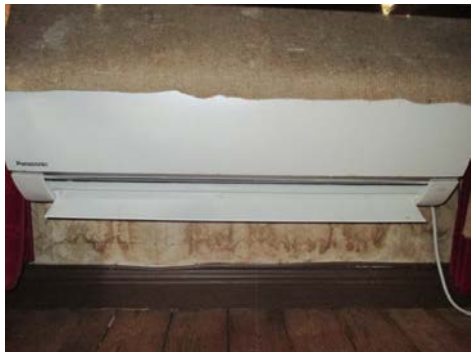
Varmepumpe er installert i hver etasje.
