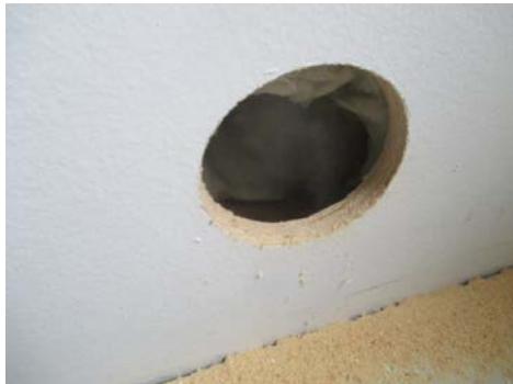
Hulltaking i fra trappegangen
