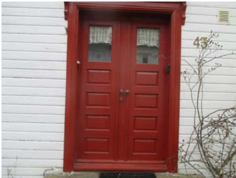
Nyere ytterdør i fra 2005
