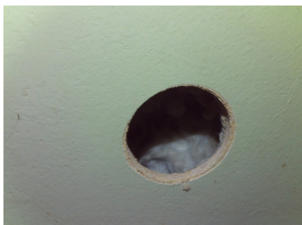
Hulltaking fra trappegangen.
