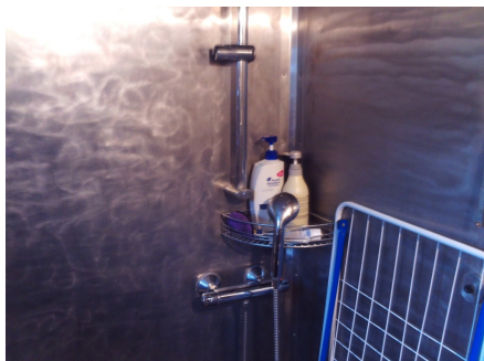
Stålplater i dusjhjørne.
