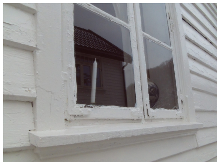
Deler av gammel kledning med tilhørende belistninger.
