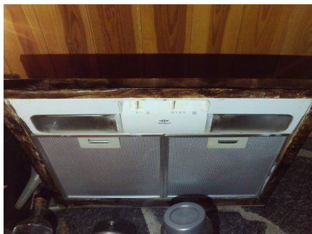
Ventilator med kullfilter.
