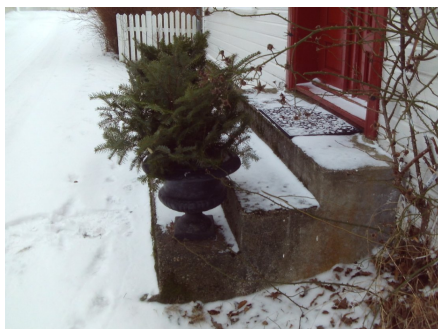
Støpt trapp til hovedinngangen.
