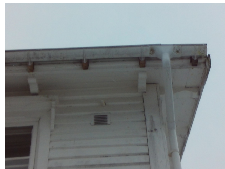
Nyere stålrenner på deler av bygningen.
