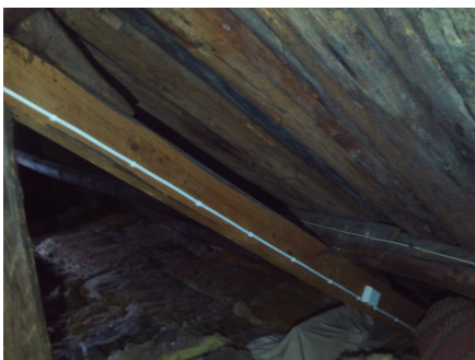
Deler av takkonstruksjonen
