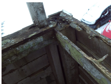
Råteskader rekkeverk.
