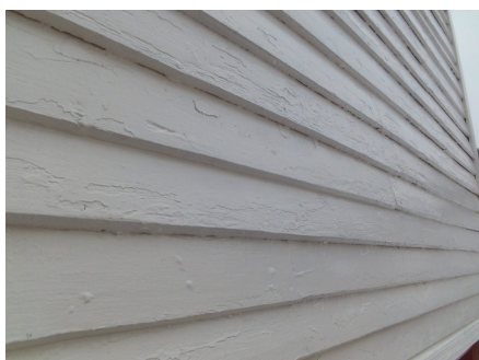
Eldre opprinnlig kledning av tykkebord.
