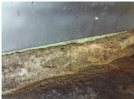
Skråoppkant av betong mot veggplater.
