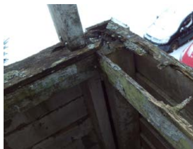
Råteskader rekkverk.
