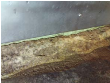
Skråoppkant av betong mot veggplater.
