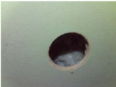
Hulltaking fra trappegangen.
