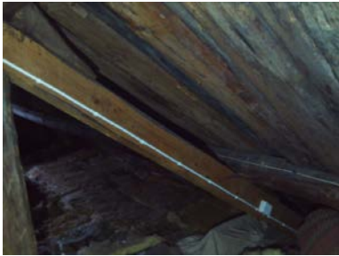
Deler av takkonstruksjonen
