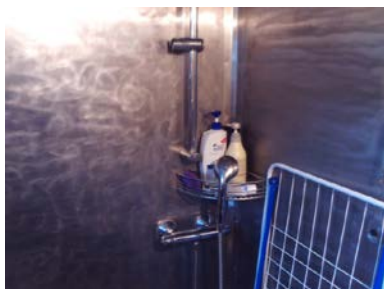
Stålplater i dusjhjørne.
