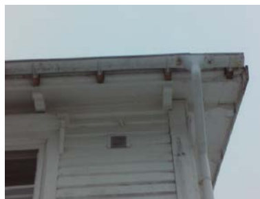
Nyere stålrenner på deler av bygningen.
