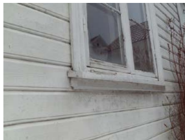
Deler av fasade som er kledd på nytt på 80- tallet.
