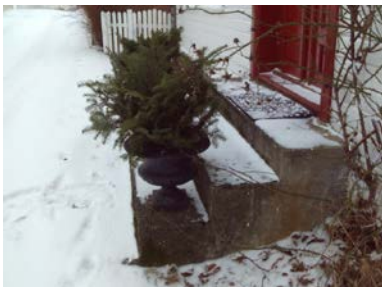
Støpt trapp til hovedinngangen.
