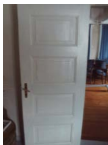
Deler av en tofløyet dør i mellom stuer.
