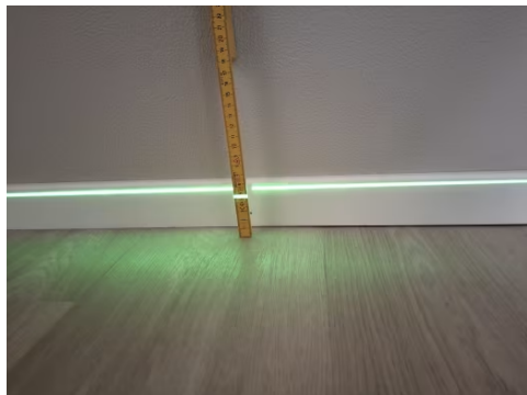
Etasjeskille er kontrollert med nivelleringslaser.
