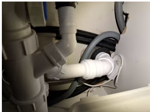
Synlige avløpsrør av plast og støpejern i leiligheten.
