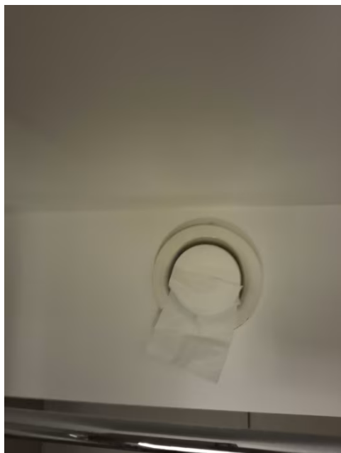
Avtrekkseffekt er testet med papir.
