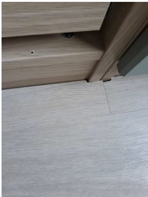
Gulv er avsluttet mot garderobeinnredning.
