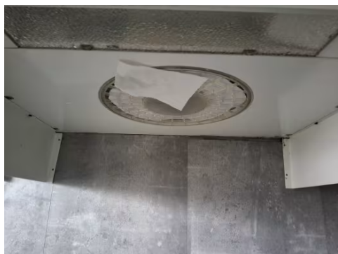
Avtrekkseffekten er testet med papir.
