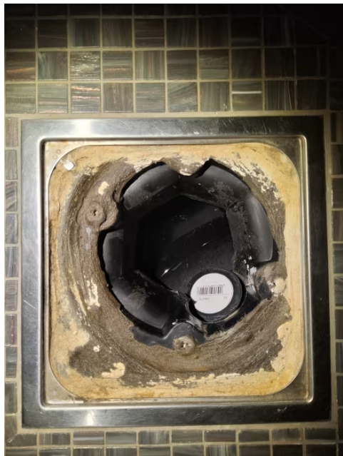
Eldre sluk på bad.
