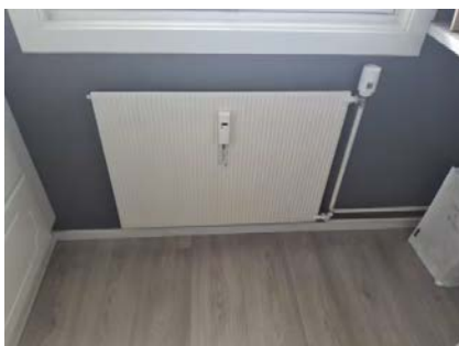
Leiligheten er oppvarmet med radiatorer tilkoblet felles fjernvarme.
