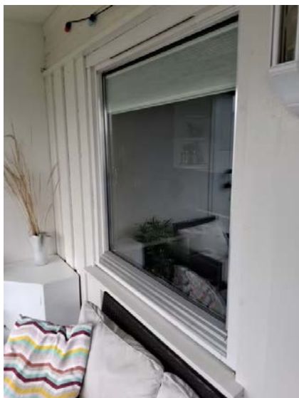
Leiligheten har vinduer med to-lags glass.
