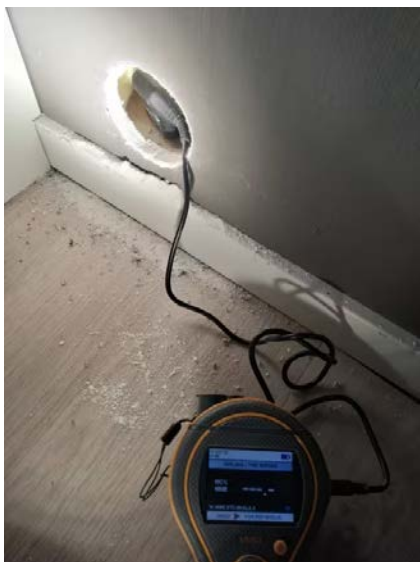
Bilde fra fuktmåling i veggkonstruksjon tilstøtende våtsone.
