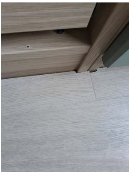
Gulv er avsluttet mot garderobeinnredning.
