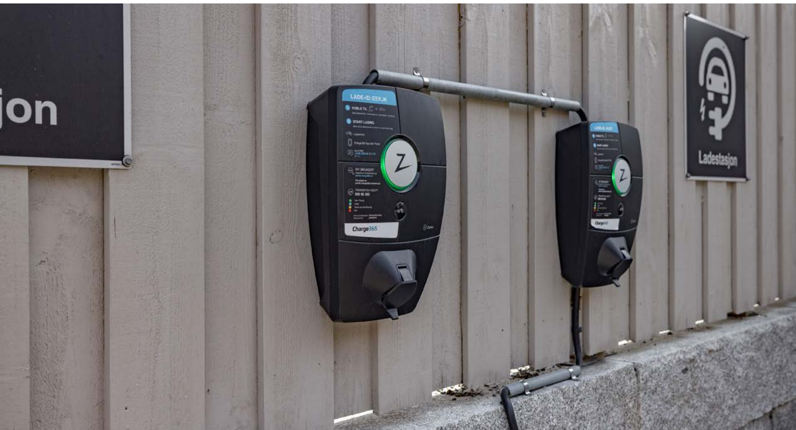
Borettslaget har montert flere elbil-ladere, og det er planlagt å montere ytterligere.
