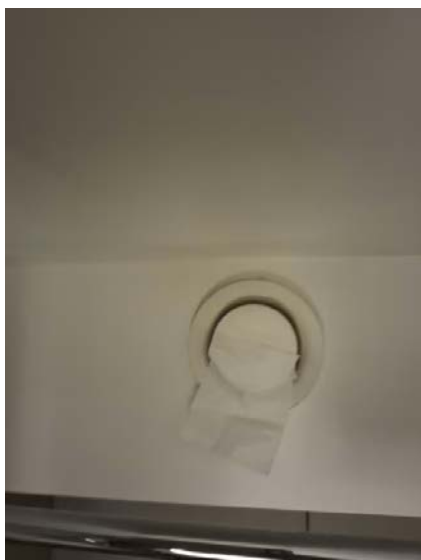
Avtrekkseffekt er testet med papir.
