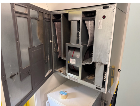
Foto viser kontroll av ventilasjon.
