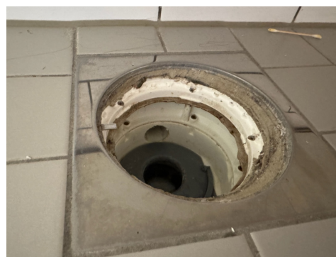
Foto viser hjelpesluk under innredning.
