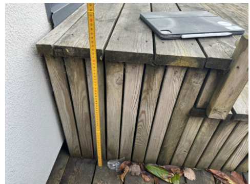
Foto viser avstand fra terrassebord til topp trapp.
