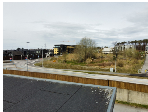
Foto viser mose på tak, registrert i hjørner og langs beslag nedover taket.
