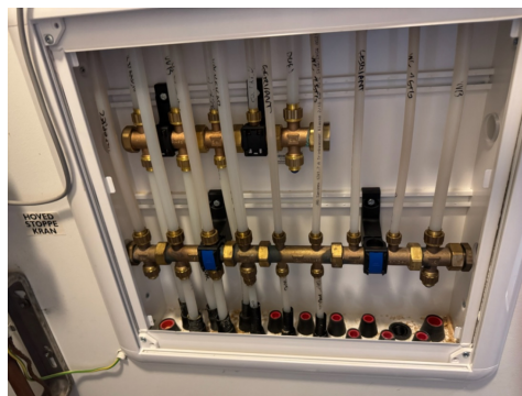
Foto viser kontroll av vannskap.
