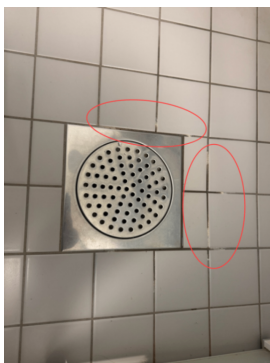
Foto viser saltutslag rundt sluk.
