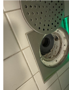
Foto viser hjelpesluk under innredning.
