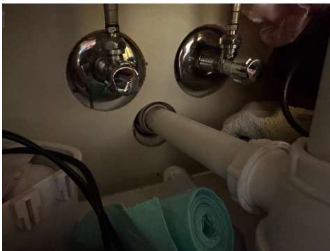
Foto viser manglende fugemasse mellom flis og avløpsrør for servant.
