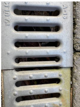
Foto viser vegetasjon i slukrenne.
