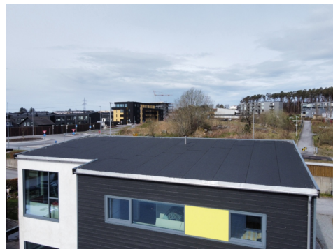
Foto viser oversikt over tak ved benyttelse av drone.
