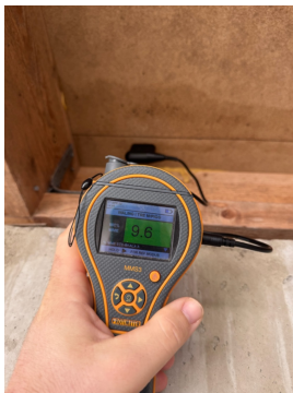
Foto viser ikke indikasjon på fukt i fuktmerke, forbehold om at dette er fra byggetidspunktet.
