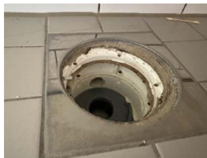
Foto viser hjelpesluk under innredning.
