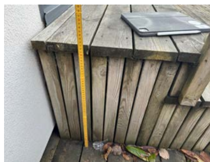
Foto viser avstand fra terrassebord til topp trapp.
