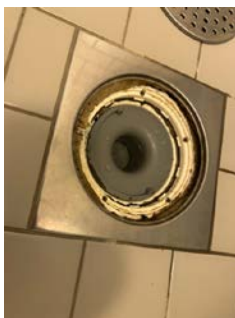
Foto viser manglende fugemasse mellom flis og avløpsrør for servant.
