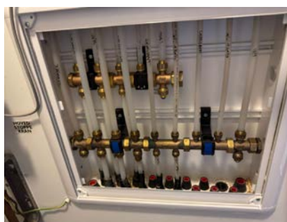
Foto viser kontroll av vannskap.
