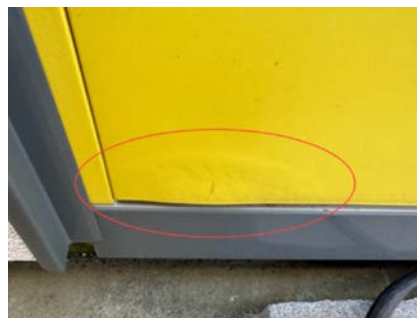
Ytterdør - vaskerom/ bi-inngang, sveller i bunn.
