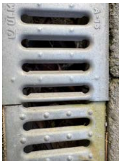
Foto viser vegetasjon i slukrenne.
