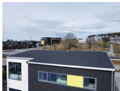
Foto viser oversikt over tak ved benyttelse av drone.
