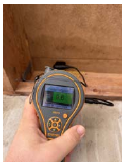
Foto viser ikke indikasjon på fukt i fuktmerke, forbehold om at dette er fra byggetidspunktet.
