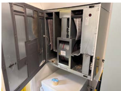
Foto viser kontroll av ventilasjon.
