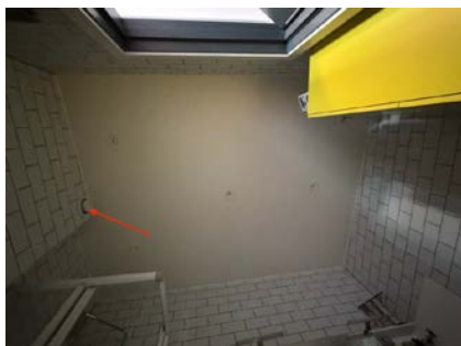
Foto viser inv. tak og ventilhette på vegg.
