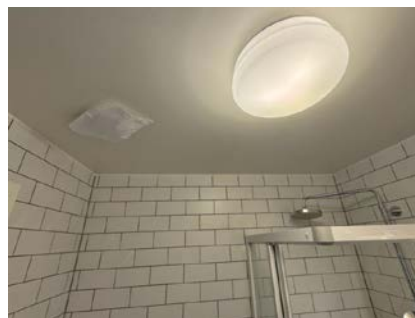
Foto viser test av ventilasjon.
