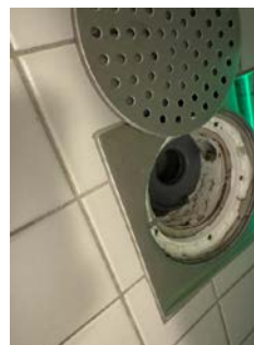
Foto viser hjelpesluk under innredning.
