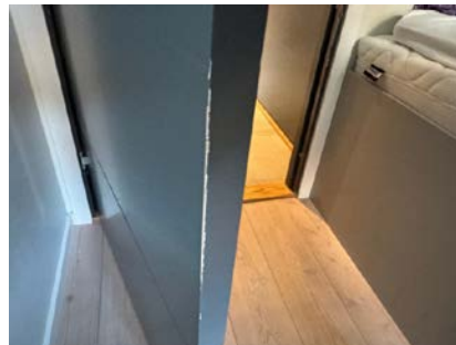
Foto viser eksempel p  overflateslitasje p  inv. d r.
