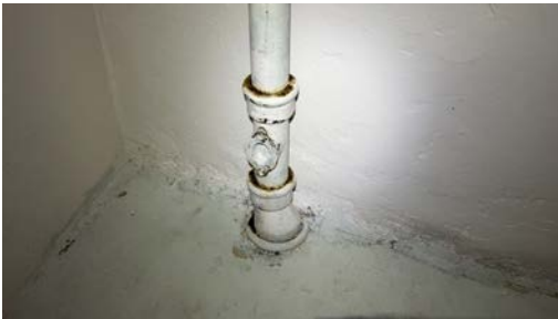
Stakepunkt i kjeller.
