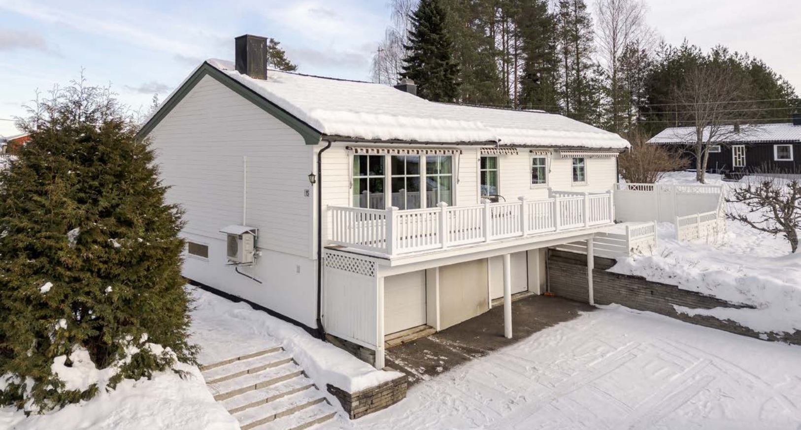
Garasje i sokkeletasjen med elektrisk port.
