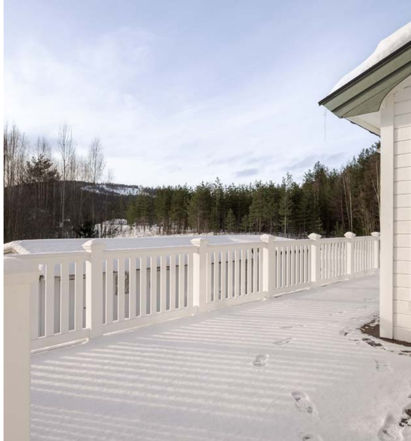
Solid gulvkonstruksjon av tre og rekkverk av PVC.
