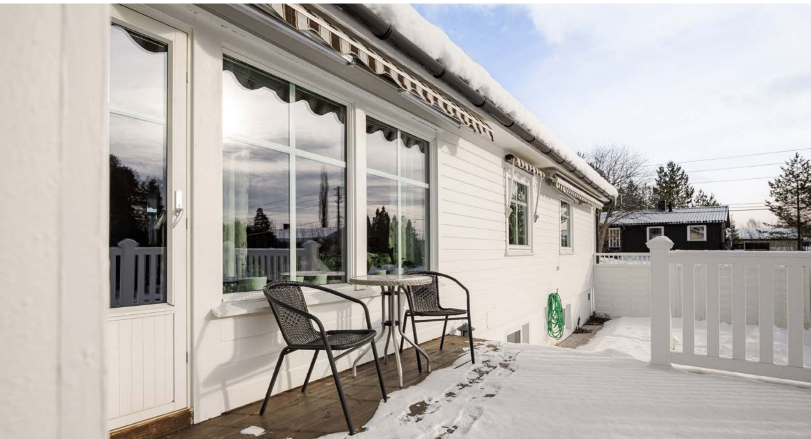
Ny terrasse bygd i 2021.
