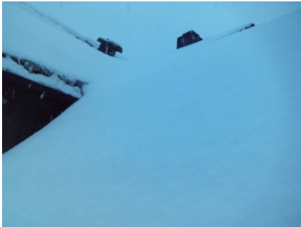
Taktekkingen var dekket av snø.
