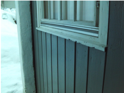
Deler av kledning med belistninger
