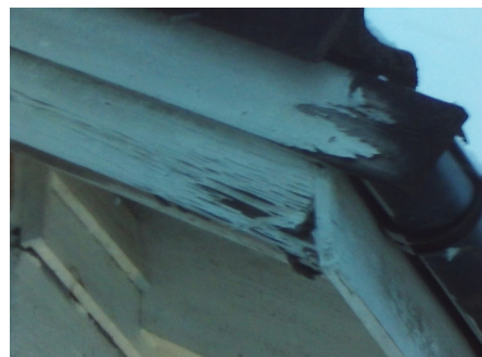
Mangler et vannbord overbygg inngangsarti.
