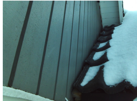
Mangler et vannbord overbygg inngangsarti.
