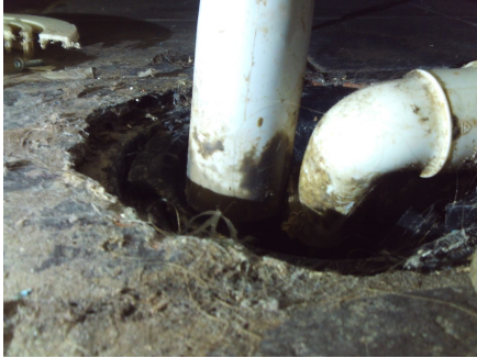
Eldre opprinnelig sluk.
