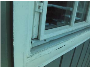
En del slitasje på utvendig karm og ramme på enkelte vinduer.
