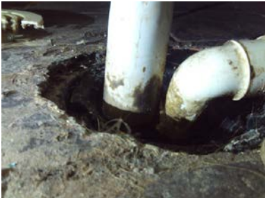
Eldre opprinnelig sluk.
