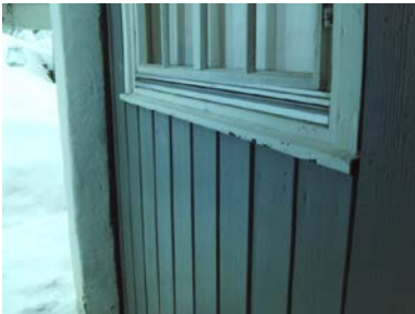
Deler av kledning med belistninger
