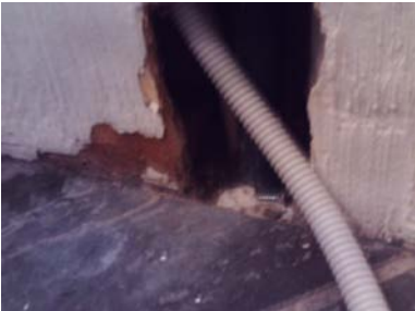
Åpning i vegg helt til gulvet mot soverom.
