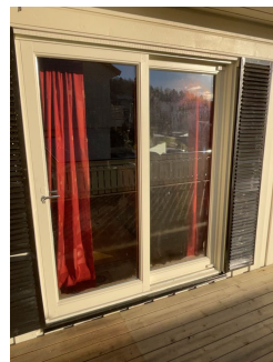
Skyvedør på stue fra 1986. Punkterte glass i begge felt
