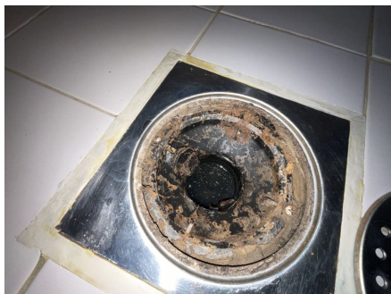
Sluk uten synlig membran
