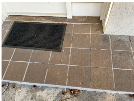
Slitte fuger, skade på enkelte fliser og saltutslag på fliser ved inngang i underetasje
