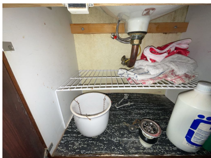
Belegg er ført ned under slukpotte
