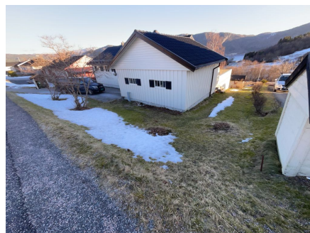
Fall på terreng mot garasje og bolig
