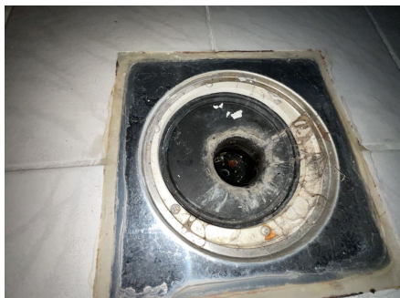
Sluk uten noe synlig membran
