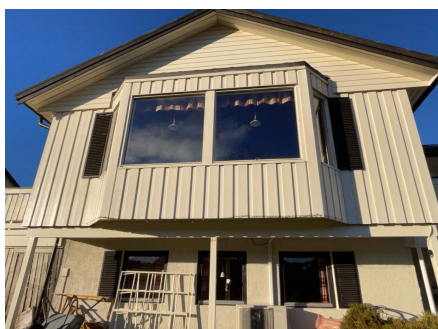
Vinduer i tilbygg er fra 1985 og 1986. Langvegg er vinduer fra 1985. Vinduer i front er fra 1986 hvor det er skiftet glass i de to store vinduene i 2010
