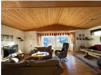
Åpen himling i tilbygg på stue
