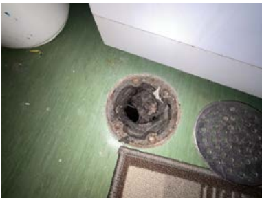
Belegg er ført ned under slukpotte
