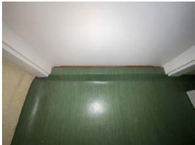
Belegg er ved dør ført opp mot dørterskel for å ivareta vannsikkerheten
