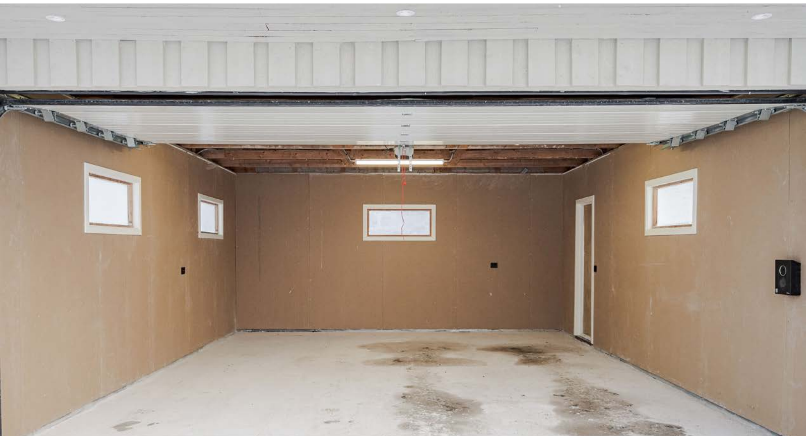
Garasjen er oppgradert i 2025 med bla. ny støpt plate, nye gipsplater på veggene, ny leddport med motorstyring og ny elbil-lader.
