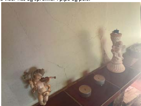
Bildene viser riss og sprekker i pipe og peis.
