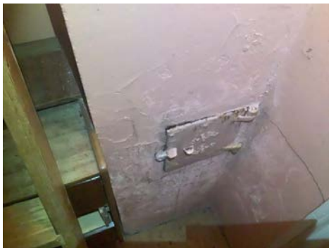
Bildene viser riss og sprekker i pipe og peis.
