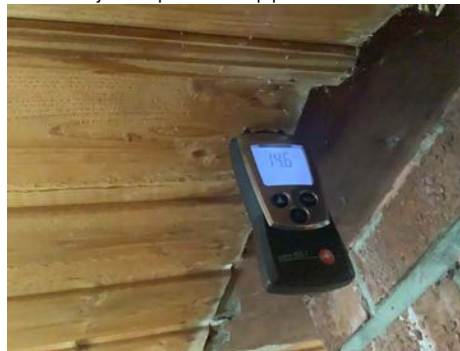
Bildet viser at det måles tørt på befaringsdagen.
