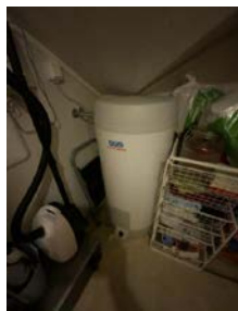
Varmtvannsbereider montert i bod.
