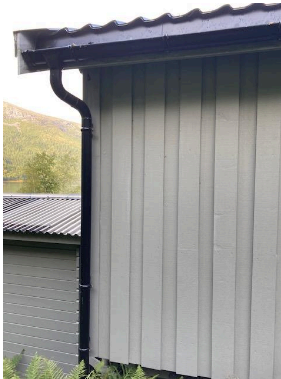
Nedløp av stål.
