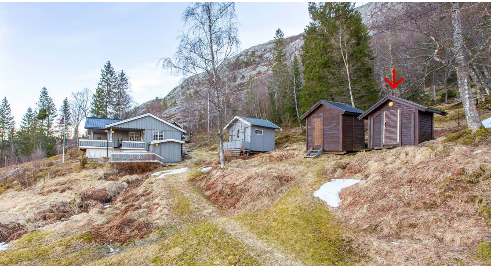
Vann hentes i brønnhuset på vinteren. (Den nærmeste bygningen)
