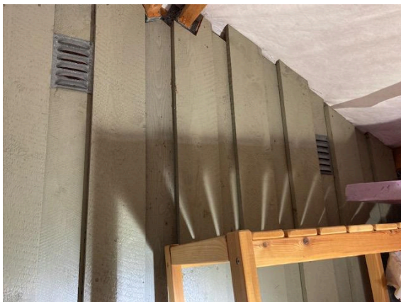
Ventiler i røstveggene
