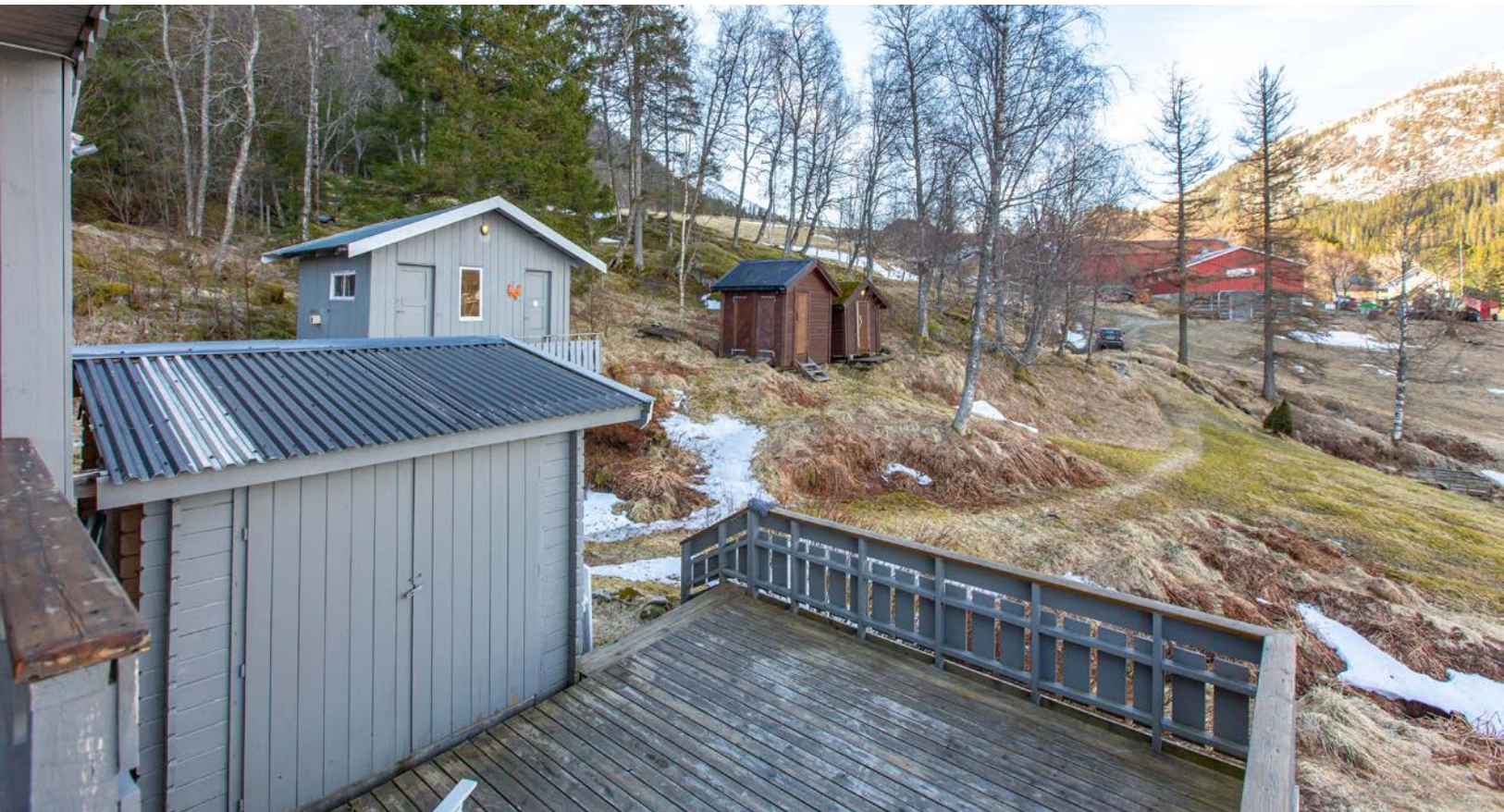
Trapp ned til plattingen
