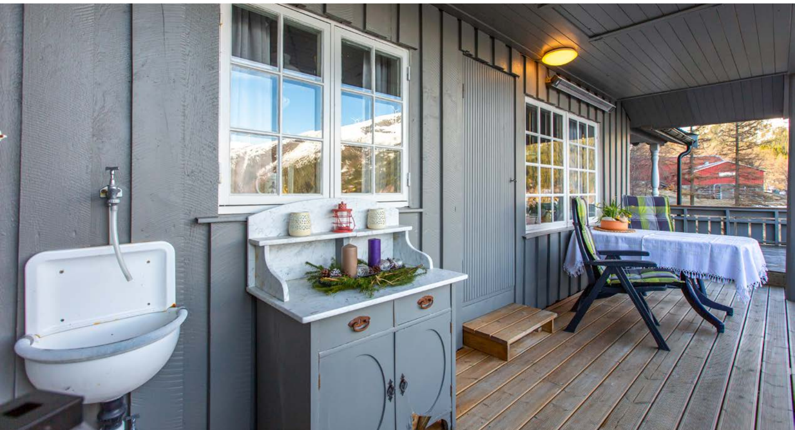
Vannpost og vask ute på altanen
