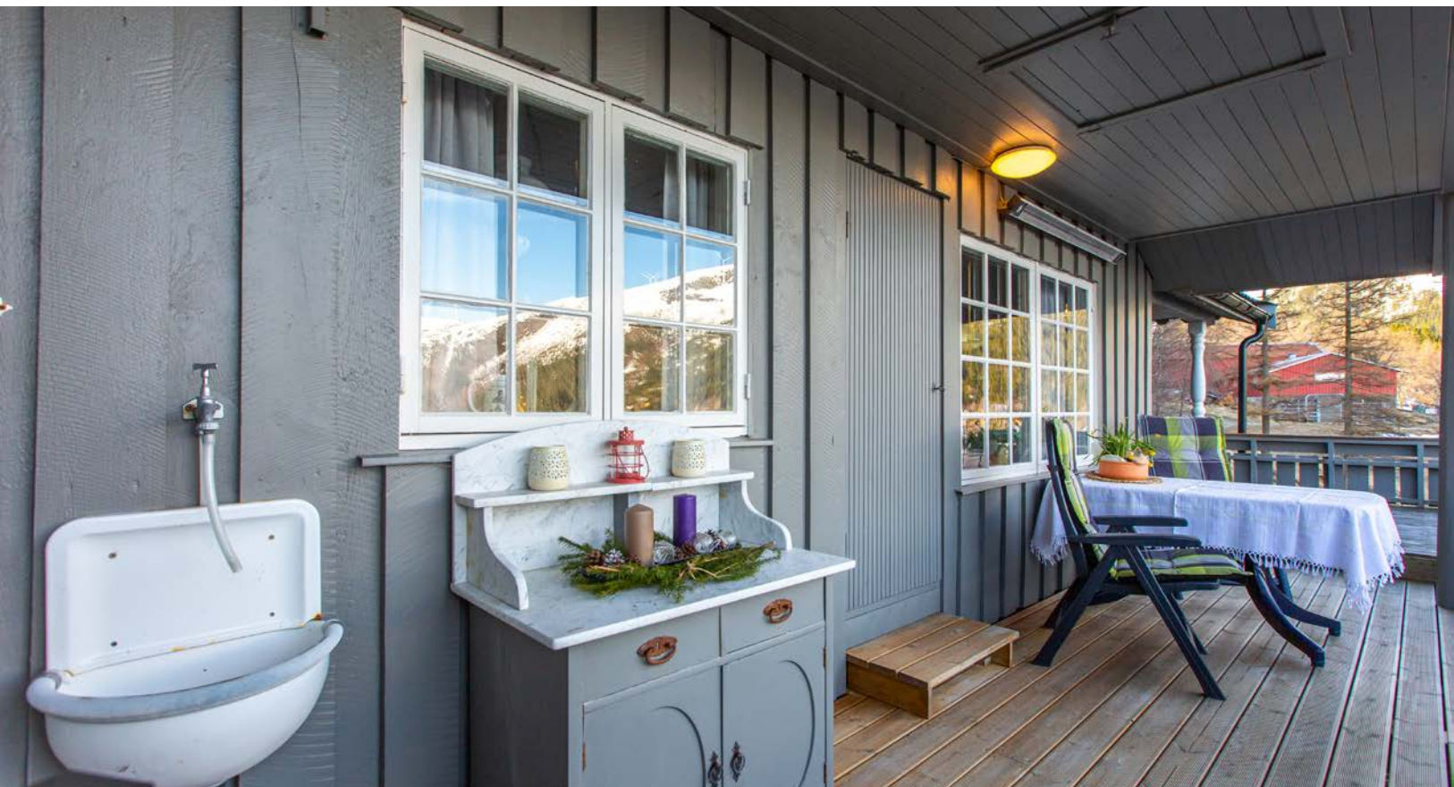
Vannpost og vask ute på altanen
