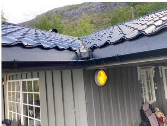
Noe rust i nedre kant på ståltaket. Mangler snøfangere.
