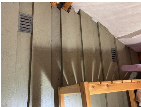
Ventiler i røstveggene
