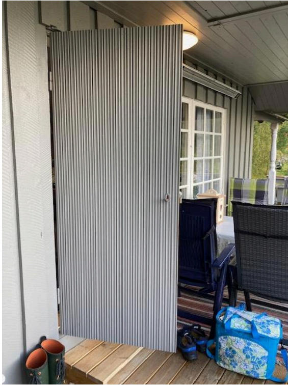
Ytterdør ut til altan.
