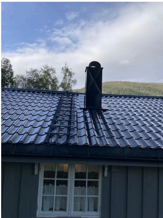
Ny takstige. Helbeslag på pipe.
