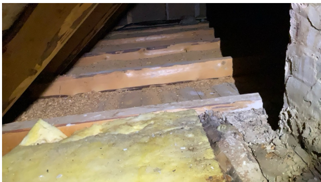
Loft opprinnelig del.
