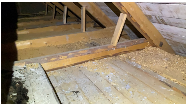
Loft opprinnelig del.
