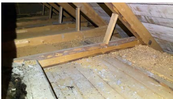
Loft opprinnelig del.
