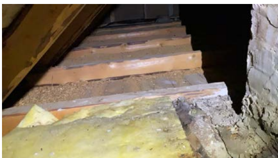
Loft opprinnelig del.
