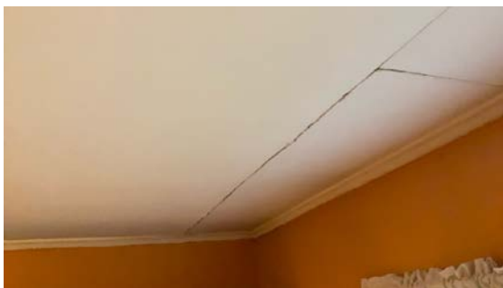
Synlig fuktskade i himlingen på kjøkkenet.
