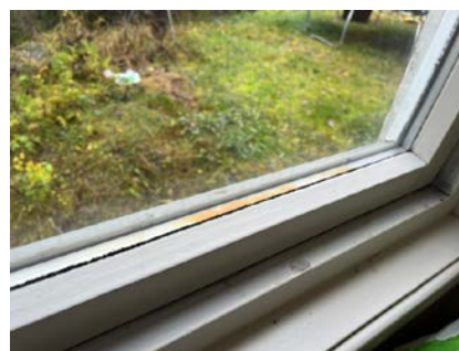
Bod-vindu med tegn til punktert glass.
