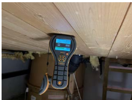
Fuktmåling viste normale verdier.
