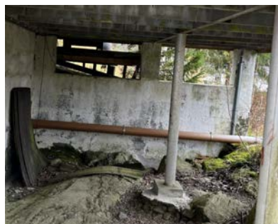
Avløpsrør må frostsikres.
