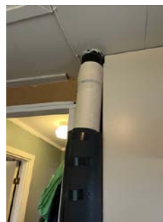
Synlig rør for avløpslufting i bod
