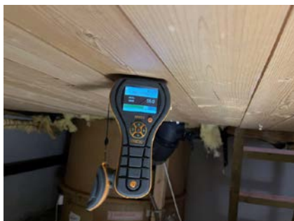
Fuktmåling viste normale verdier.
