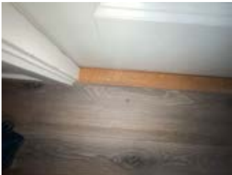
Slagskade på laminatgulv i gang ved dør til soverom 1
