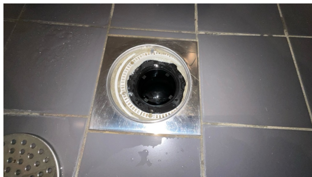
Kontroll av sluk.
