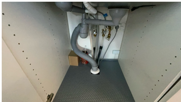
Besiktigelse av røropplegg.
