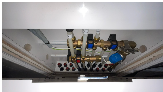
Besiktigelse av røropplegg.
