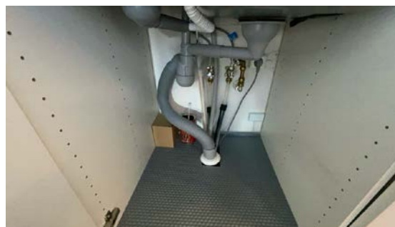
Besiktigelse av røropplegg.
