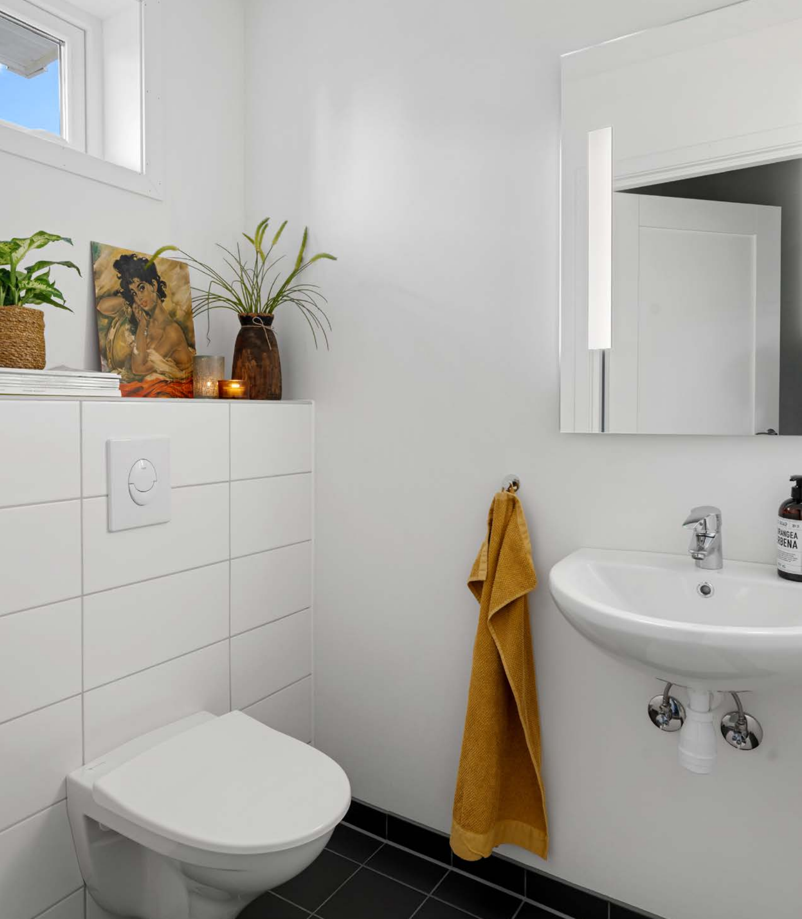
Wc-rom med fliser på gulv og gulvvarme. Innredet med vegghengt toalett, servant og speil med belysning.
