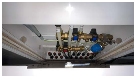
Besiktigelse av røropplegg.
