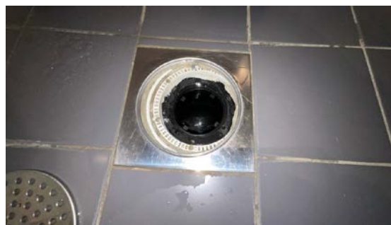
Kontroll av sluk.
