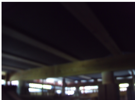
Deler av stubbloftet på tilbygget del.
