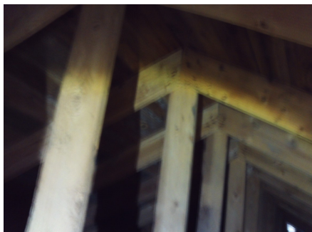
Deler av kaldtloftet over opprinnelig del.
