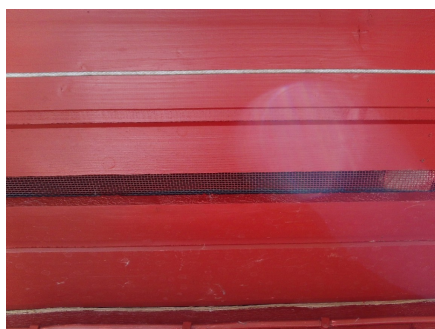
Gode luftespalter i gesimser for tilgang på luft til kaldtloftet
