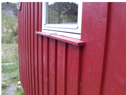
Deler av kledning med tilhørende belistninger som er blitt byttet
