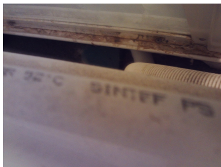
Avløp fra vask og dusjkabinett er før i rør ut av rommet.
