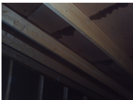
Deler av kaldtloftet over tilbygget del.
