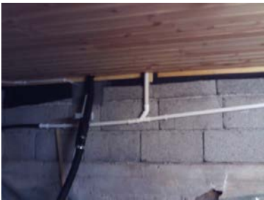
Deler av ringmur og nytt stubbloft av panel.
