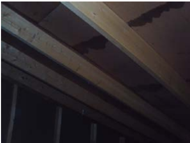
Deler av kaldtloftet over tilbygget del.
