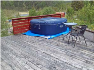
Deler av terrasse vpå enden av tilbygget del.
