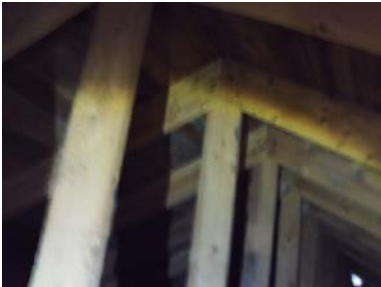
Deler av kaldtloftet over opprinnelig del.
