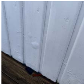
Kledning lite avstand til terreng og råte nederst mot terreng.
