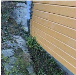
Kledning lite avstand til terreng og råte nederst mot terreng.
