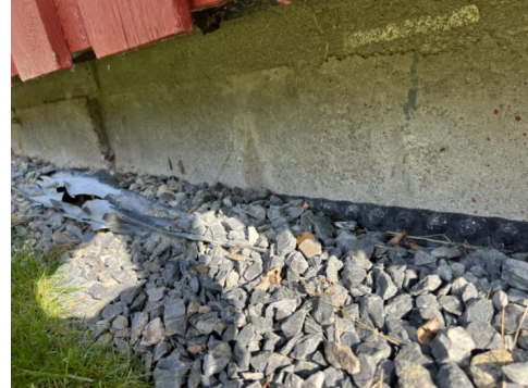
Synlig drensplast er lav og dels under terreng
