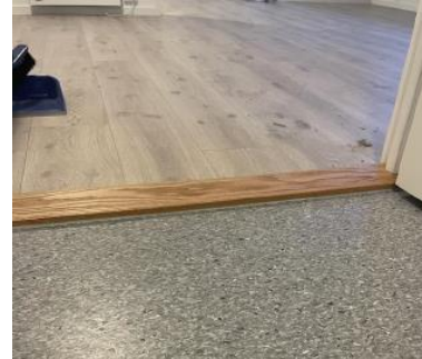
Flat terskel med tilluft er montert etter befaringen. Det ble da også fuget mellom belegget og dørterskel for å bedre vannsikkerheten.
