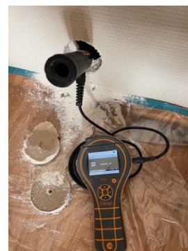
Fuktmåling i vegg mot våtsone.
