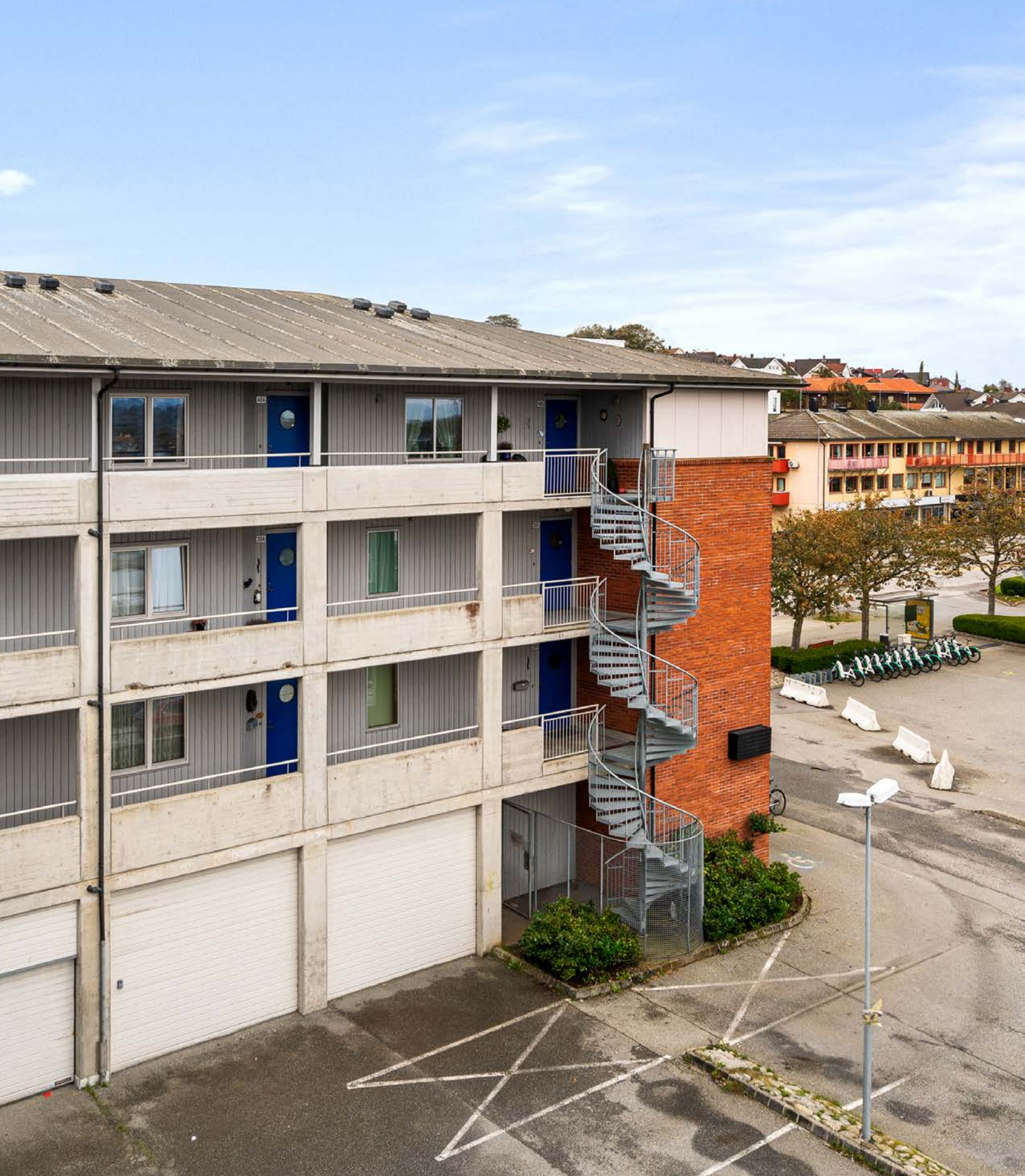
Parkering og bod i lukket parkeringsanlegg
