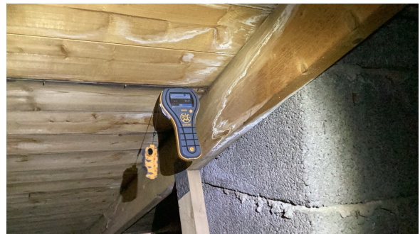
Ved enkel fuktmåling registrerte jeg tørre verdier.
