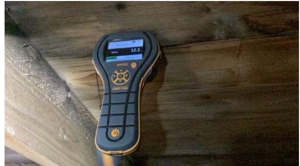
Ved enkel fuktmåling registrerte jeg tørre verdier.
