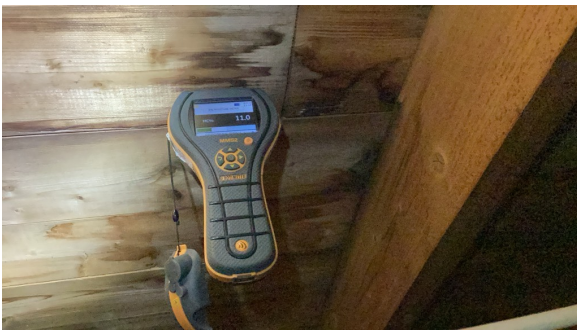
Ved enkel fuktmåling registrerte jeg tørre verdier.
