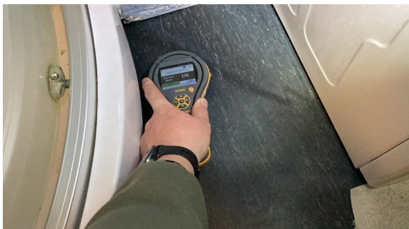
Ved bruk av fuktindikator på utsatte steder registrerte jeg ingen unormale verdier.
