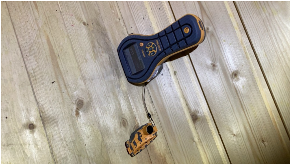
Ved enkel fuktmåling registrerte jeg tørre verdier.
