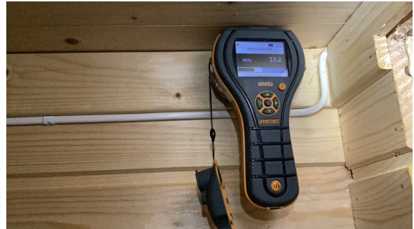
Ved enkel fuktmåling registrerte jeg tørre verdier.
