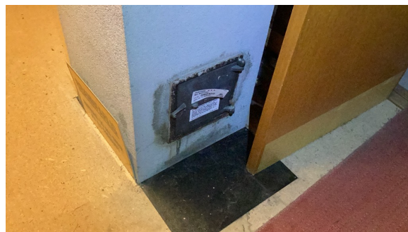
Feieluke på bod i kjeller.
