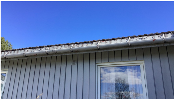
Lakk/folie flass på beslag.
