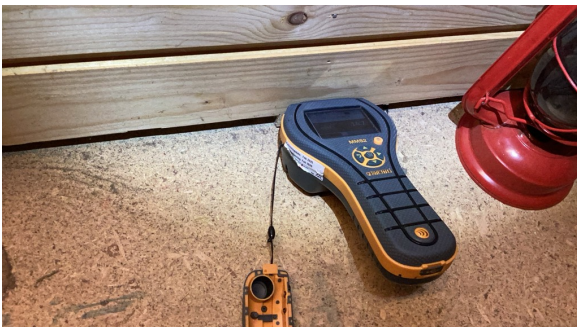
Ved enkel fuktmåling registrerte jeg tørre verdier.
