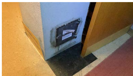
Feieluke på bod i kjeller.
