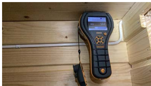
Ved enkel fuktmåling registrerte jeg tørre verdier.
