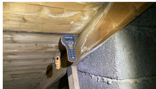
Ved enkel fuktmåling registrerte jeg tørre verdier.
