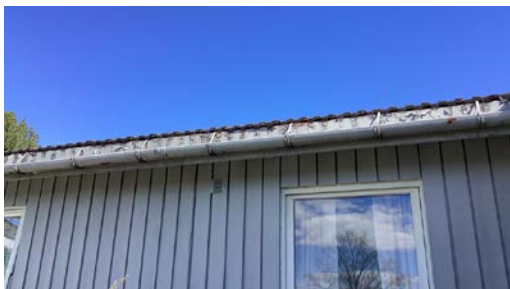
Lakk/folie flass på beslag.
