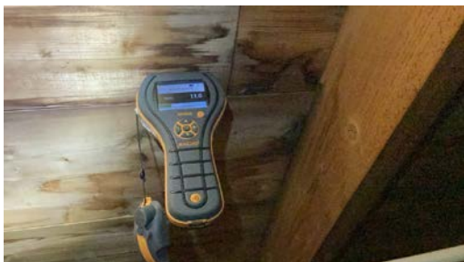
Ved enkel fuktmåling registrerte jeg tørre verdier.
