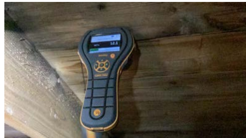
Ved enkel fuktmåling registrerte jeg tørre verdier.
