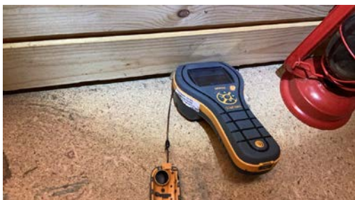
Ved enkel fuktmåling registrerte jeg tørre verdier.
