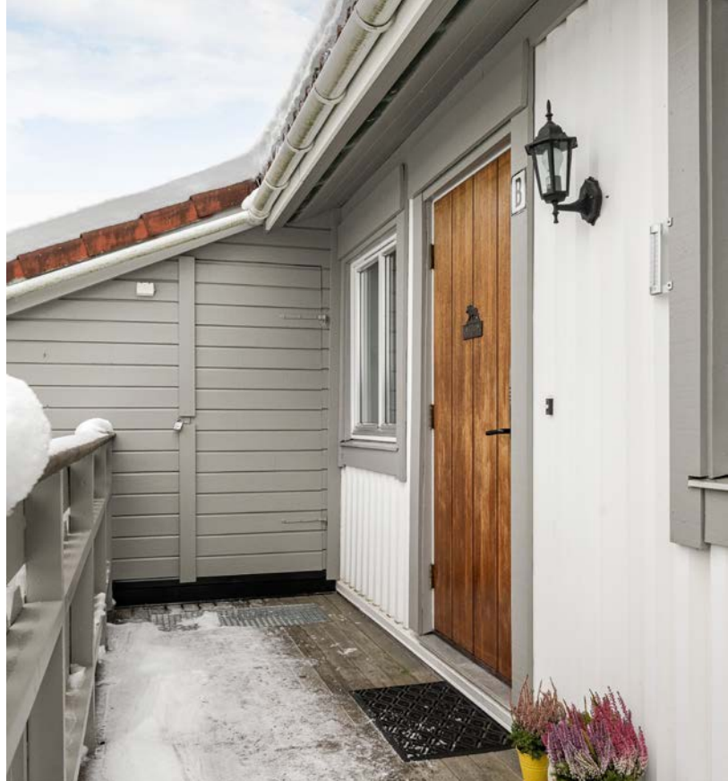
Ved inngangspartiet har du adgang til en praktisk utvendig bod på ca. 3m 2 med lys og strøm.
