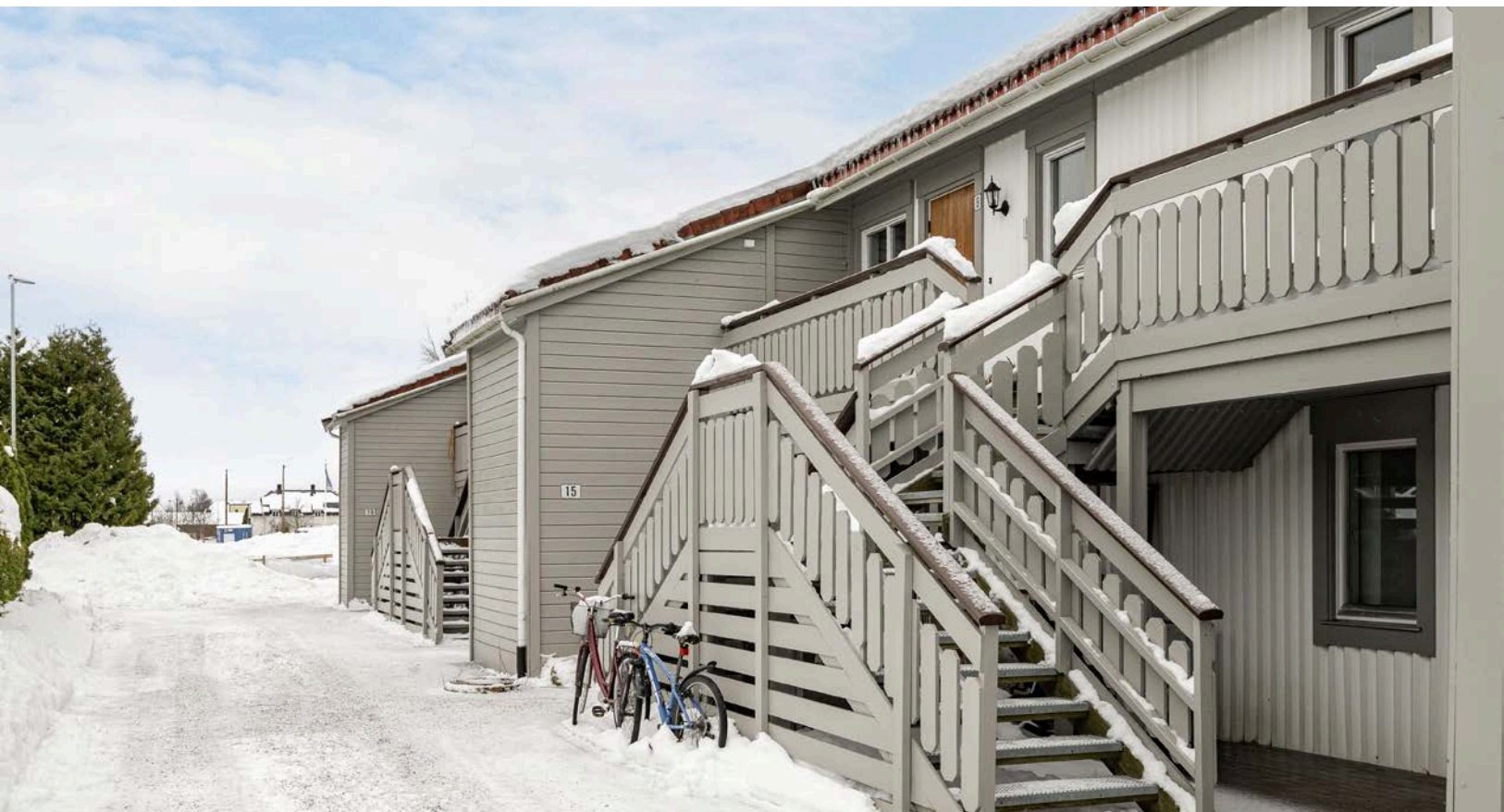
Bygget er fra 1992 og kledningen er sist overflatebehandlet i 2021. Leiligheten ligger i byggets 2. etasje som har adgang via utvendig trapp.
