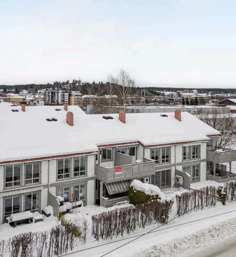
En lys og velholdt 3-roms selveierleilighet beliggende i 2. etasje i en 12-mannsbolig.
