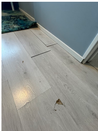
Store skader og glipper i laminat
