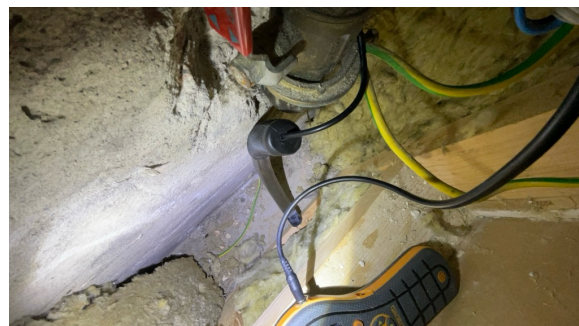
Måling fra inspeksjonsluke i trapperom
