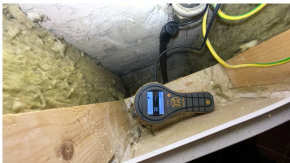
Måling med pigg i bunnsvill fra inspeksjonsluke i trapperom
