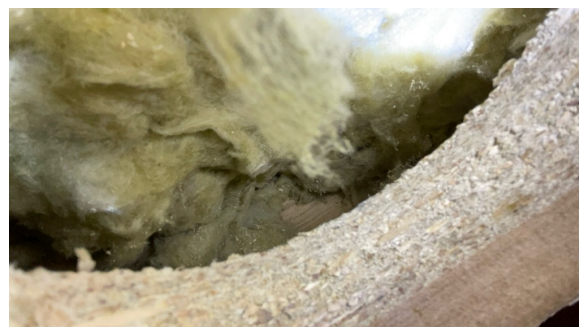
Bildet er tatt i hulltakingen i hybelen.
