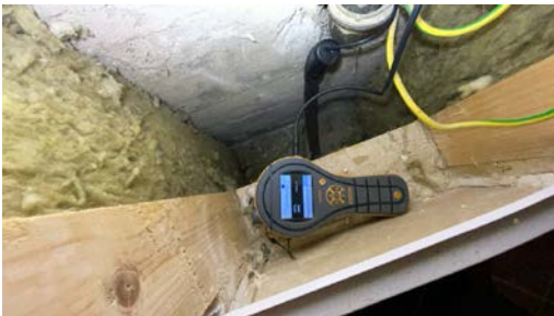
Måling med pig i bunnsvill fra inspeksjonsluke i trapperom
