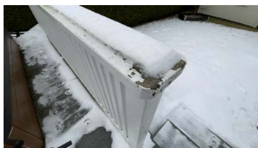
Vedlikeholdsetterslep rekkverk.
