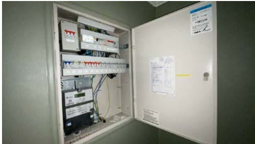
Sikringsskap hoveddel
