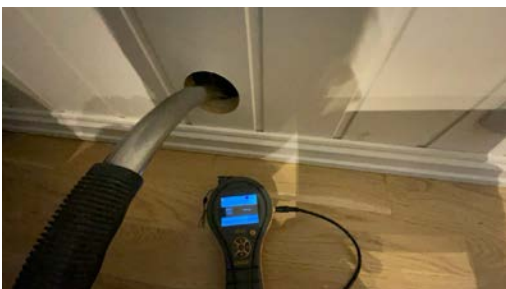
Måling med pig i hulltaking i hybelen
