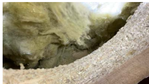
Bildet er tatt i hulltakingen i hybelen.
