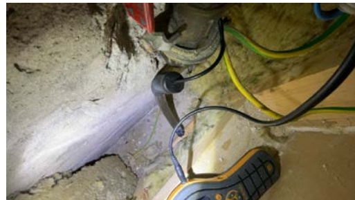
Måling fra inspeksjonsluke i trapperom
