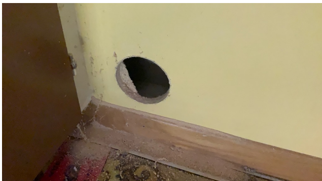
U. ETASJE > BAD/WC/VASKEROM
