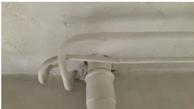
Rørgjennomføringer til vaskerommet sett fra undersiden.
