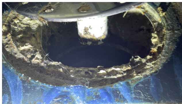
U. ETASJE > BAD/WC/VASKEROM
