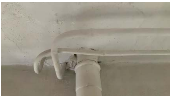
Rørgjennomføringer til vaskerommet sett fra undersiden.
