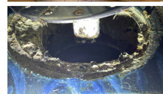
U. ETASJE > BAD/WC/VASKEROM
