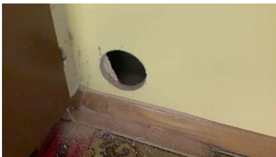
U. ETASJE > BAD/WC/VASKEROM
